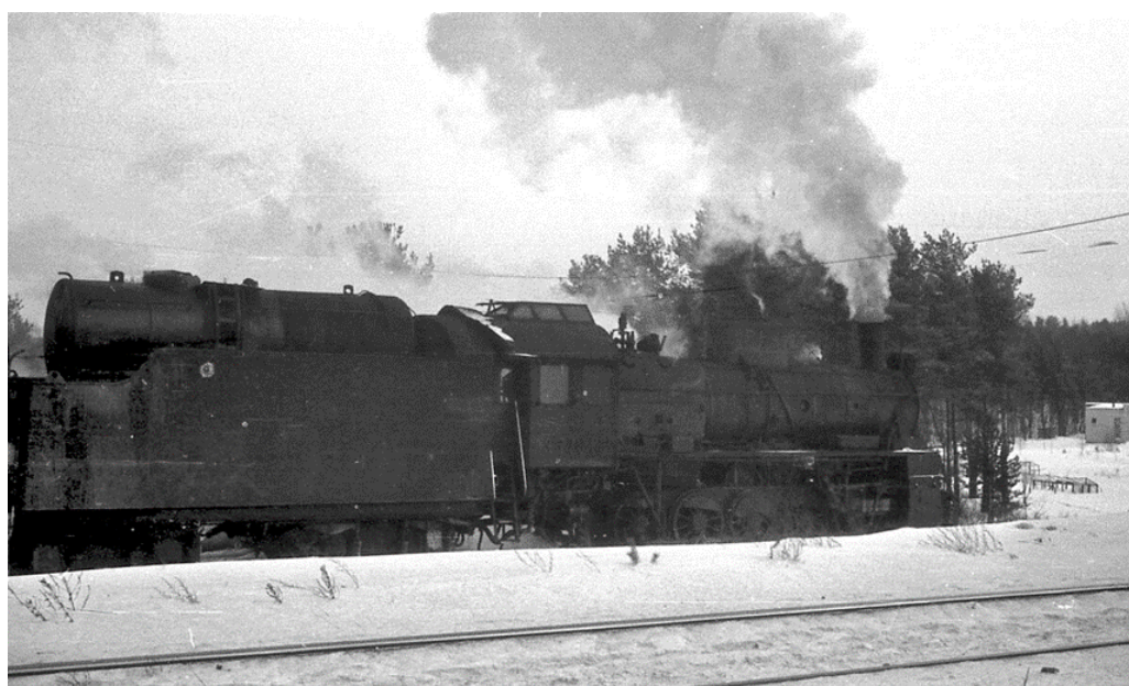
Станция Токсово в 1930-е годы. [10]
